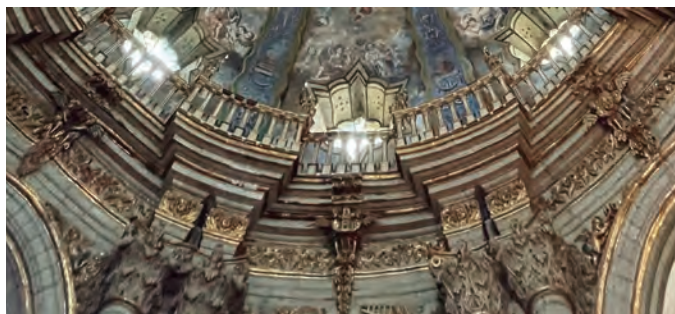
a BALAUSTRADA: Baranda. Barandal. 1. Hilera de balaustres* unidos por dos elementos horizontales, uno como base y otro como coronamiento, para formar la barandilla o antepecho. *BALAUSTRE. Cada uno de los pequeños pilares que se alinean, sujetos por el pasamano para formar una balaustrada.
