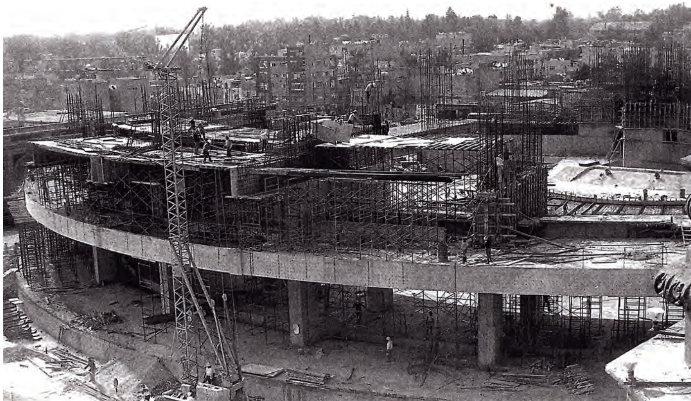
Trabajos de construcción del exterior de la Basílica de Guadalupe, s/f. Fotografía Comunicación Social de la Basílica de Guadalupe.
